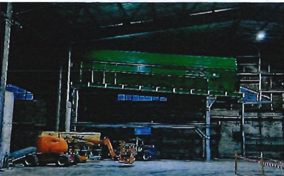
24 novembre - Installation du nouveau trommel
